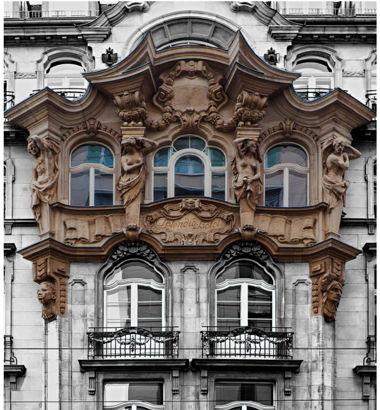
Hervorhebung besonderer Fassadenelemente durch künstlich erzeugten Farbkontrast (Berlin, Hotel Splendid)
